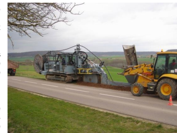
Figure 13 : Réalisation de la tranchée
