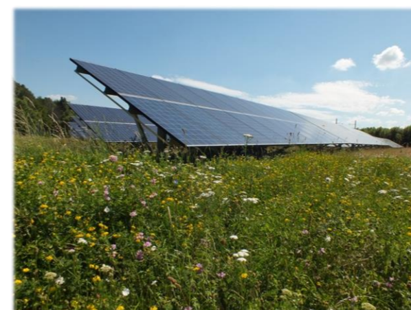
Figure 19 : Ensemencement du parc à Saint-Georges-les-Bains (07) - Structure fixes
