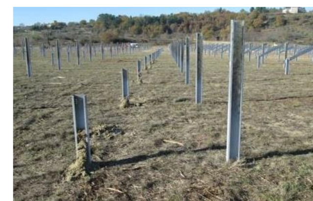
Figure 9 : Ancrage de pieux battus
