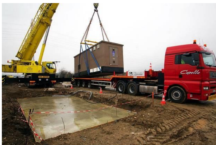
Figure 10 : Installation d'un poste de livraison
