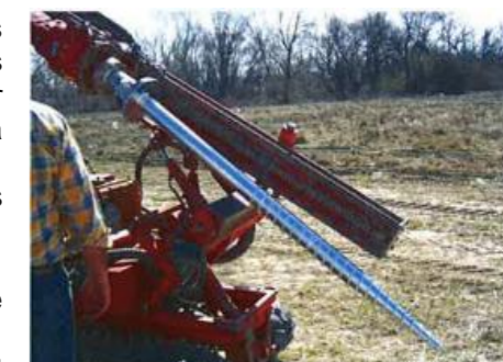
Figure 7 : Mise en œuvre de pieux
