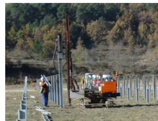
Figure 8 : Battage de pieux
